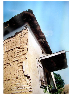
Pigeonnier en pisé construit en 1762
