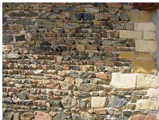
Mur de moellons avec chaîne d'angle harpée à Taylan
