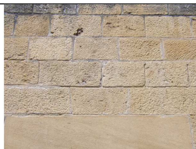
Joints fins sur pierre de taille : façade de l'église
