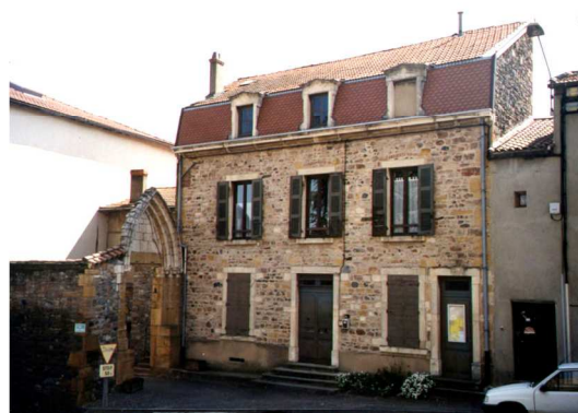
Toiture à la Mansard. Savigny.
