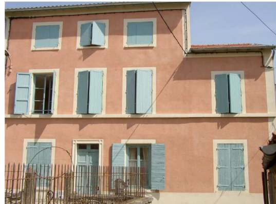
Une façade repeinte récemment. Savigny.
