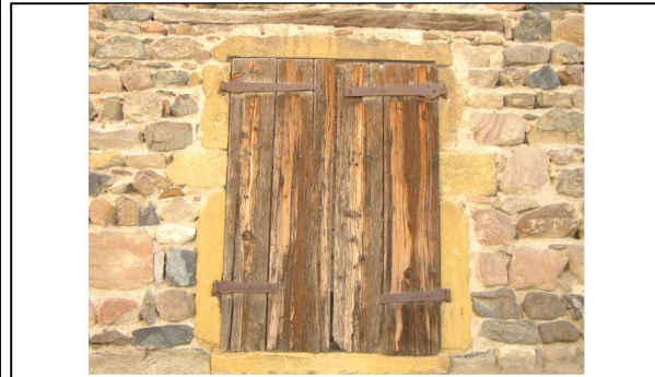
Volets à lames horizontales sur traverses métalliques. Savigny.
