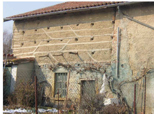
Mur en pisé coffré. La Métralière
