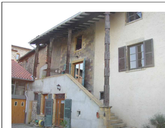
Maison de type beaujolais : escalier et galerie. Savigny
