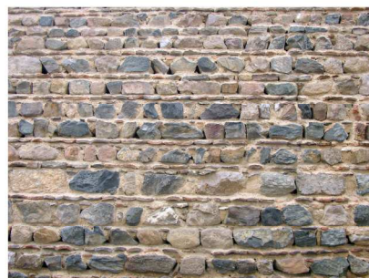
Très beau mur de moellons, régulé par des assises de briques, fragments de tuiles ou petites pierres. Savigny.
