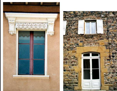
Porte et fenêtre classiques. Savigny.
