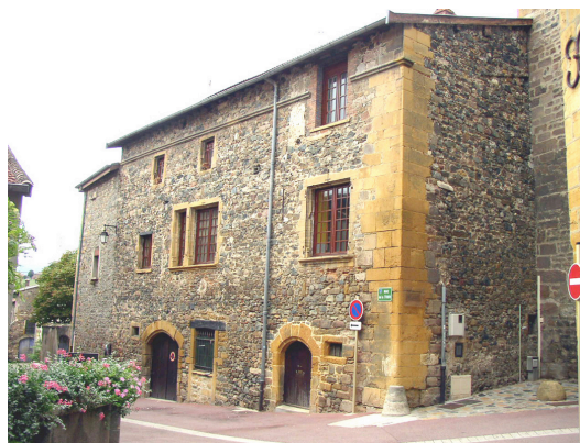
Beau chaînage d'angle : ancien hôtel du Cellierier
