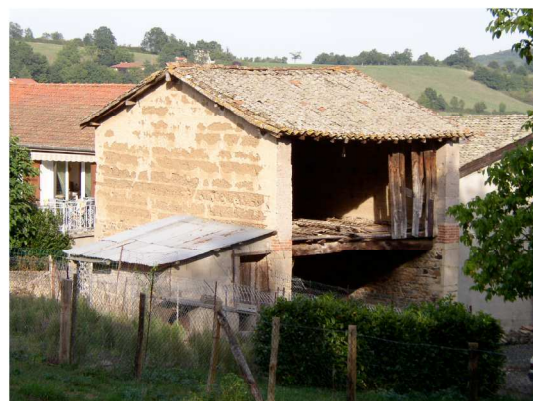
Mur en pisé d'un petit bâtiment agricole, avec vestiges d'enduit. Savigny.
