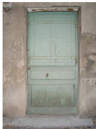
Porte d'entrée : l'imposte est condamnée par un volet croché. Savigny
