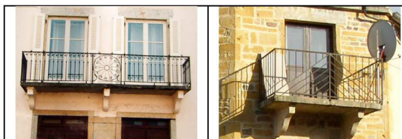
Deux balcons de Savigny
