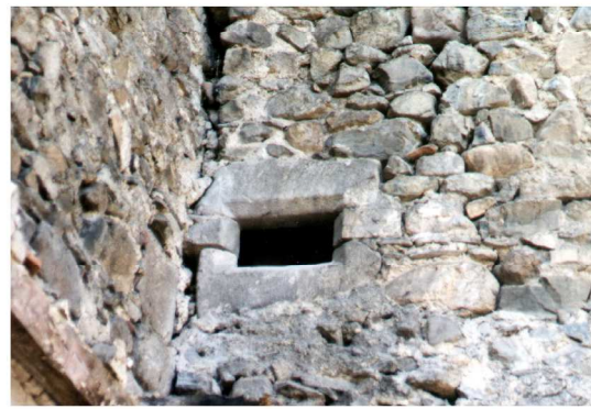
Maison datée du XVI ème siècle, avant et pendant la démolition. Novembre 2002
