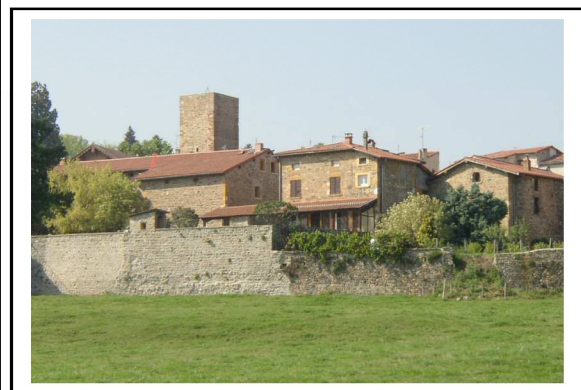
Rempart modifié et utilisé comme mur de soutènement
