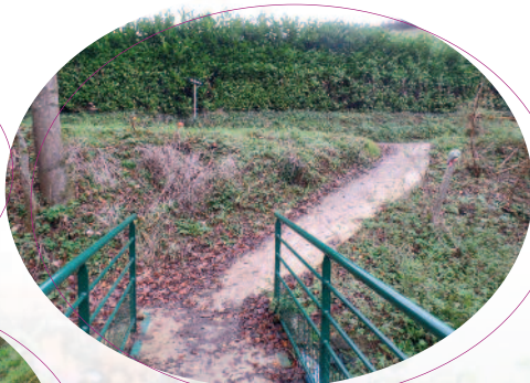
Passerelle de Mont Piollier
